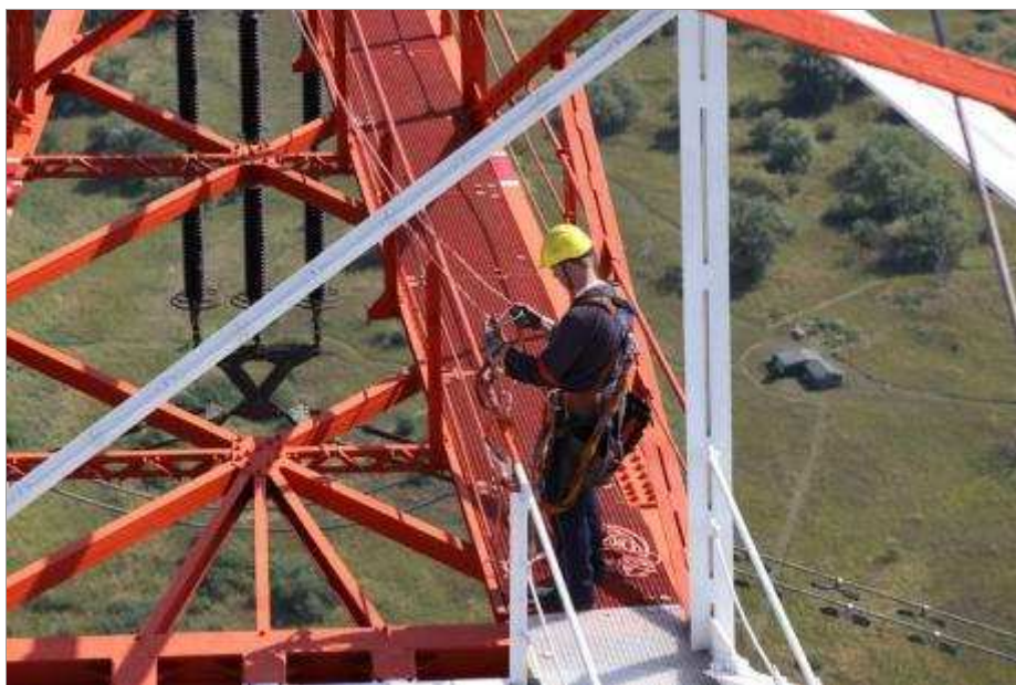
Ob und wo die neuen Masten für die geplante 380.000-Volt-Trasse gebaut werden, muss die Planfeststellungsbehörde in Hannover entscheiden Foto: Kerstin Lorenz
