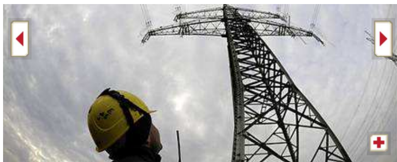
Ein Arbeiter blickt einen Strommast hinauf. Der Ausbau der Versorgungsnetze geht in Deutschland nicht schnell genug. Foto: dapd Bild 1 von 2
